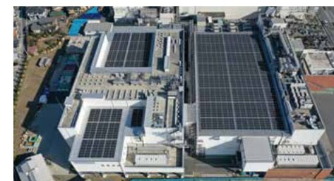
群馬工場の太陽光発電設備
